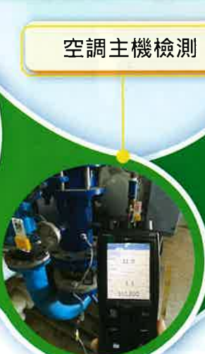
設備機房溫度檢測
